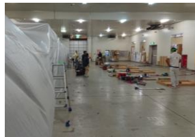
(防水施工)試験
